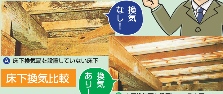
B 床下換気扇を設置している床下
